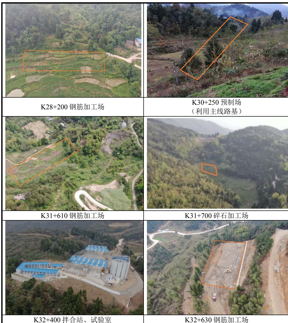
图4.1.4 施工场地现状图
