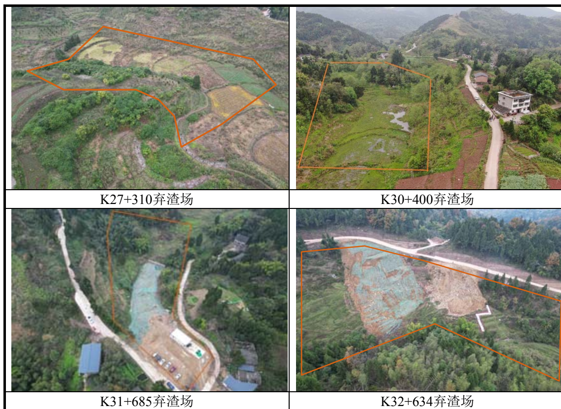
图4.1.3 弃渣场现状图
