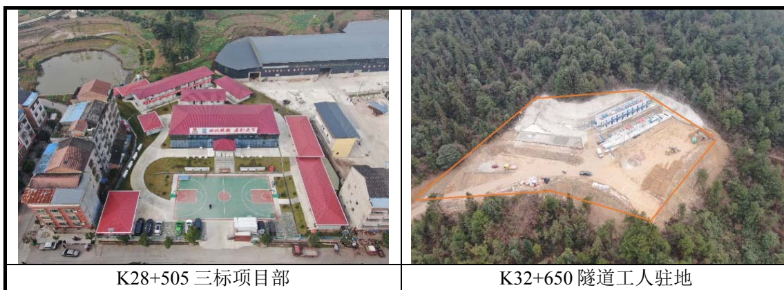
图4.1.5 施工驻地现状图
